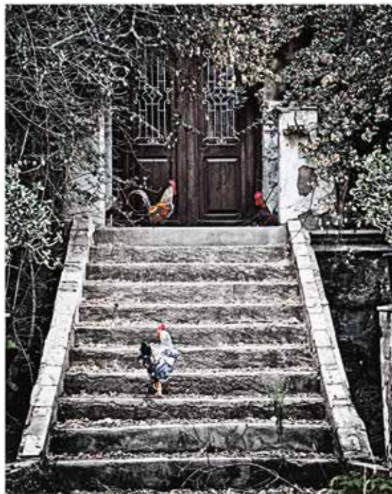
20 Sento Rovira. Pasarela
